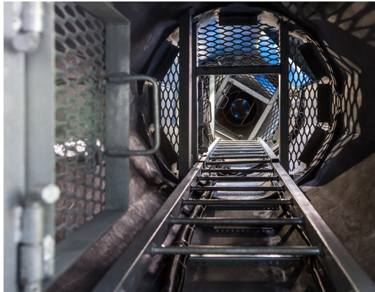
Лестница для подъёма на эксплуатационные площадки внутри тела опоры
