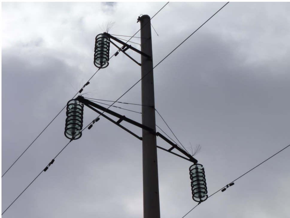
Установка ГИРМК на промежуточную опору
