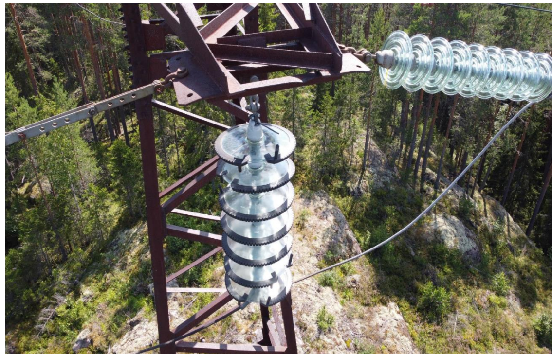
Установка ГИРМК на анкерную опору
