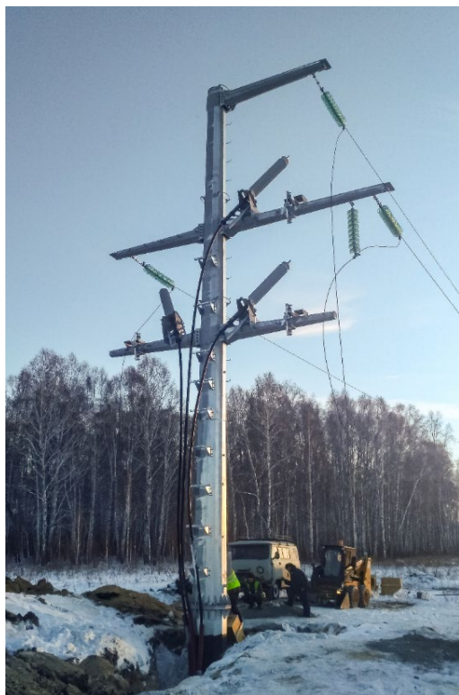
Монтаж ПКПО-КВ-110.1-1.1, Томино, Челябинская область
